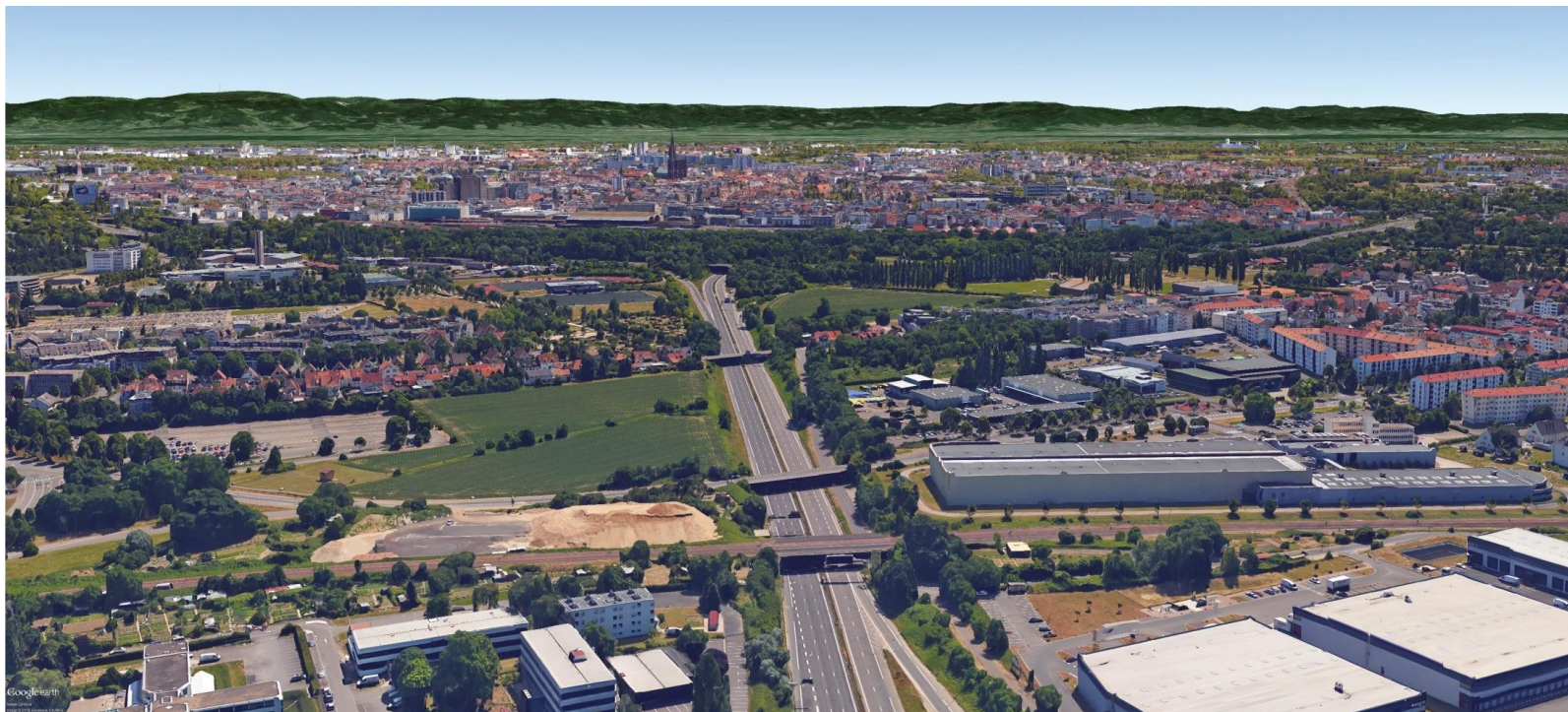
L'A351 en direction du centre ville
